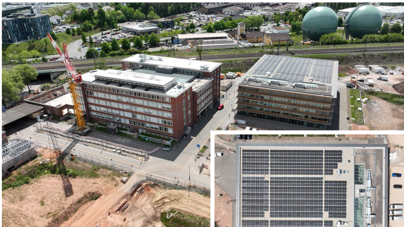
Bild 7 + 8. Das neue MVZ mit dem benachbarten Parkhaus (PV-Anlage MVZ-Parkhaus, ca. 280 kWp) [IG-CP mbH]
