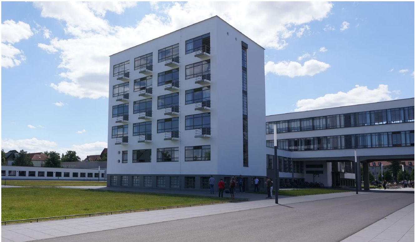
Bild 3. Atelier (Prellerhaus) mit Wohnungen für die Studenten
