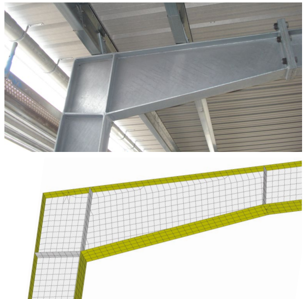
Bild 13. a) Ausgeführte Rahmenecke b) Diskretisierung als 3D-Faltwerk
