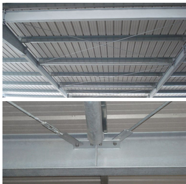
Bild 3. Dachverband (Ausschnitt: Pfosten als Druckrohr, Kreuzverband aus Rundstählen mit Spannschloss)
