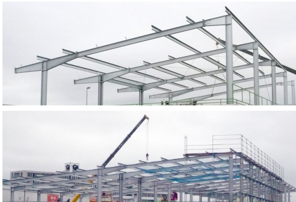
Bild 2. Montagezustand a) Z-Pfetten b) Rahmenkonstruktion
